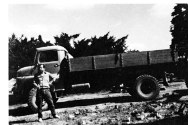
Eine Flotte von Baufahrzeugen sorgt für den Abtransport des Bauschutts.
