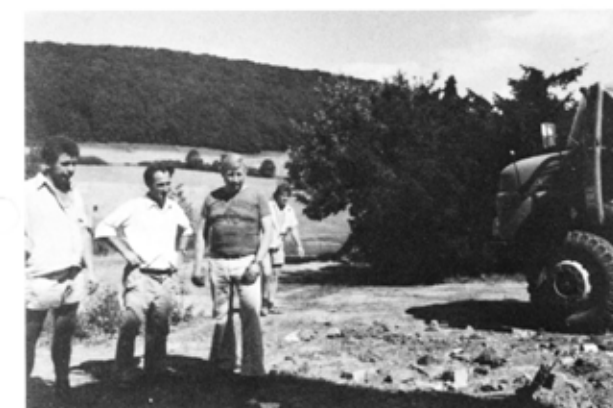
Die Terrasse ist abgerissen
