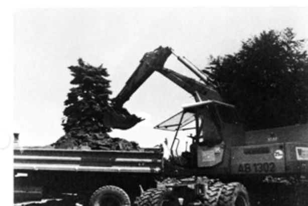
Baumaschinen des Golf-Freundes Maeck schaffen eine neue Grube für den Anbau.
