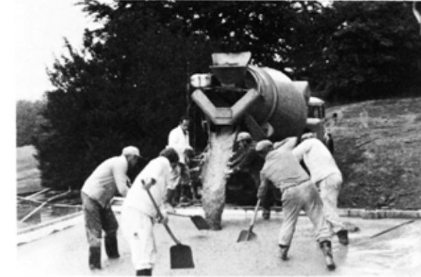
Tempo, der Mörtel für die Terrasse läuft
