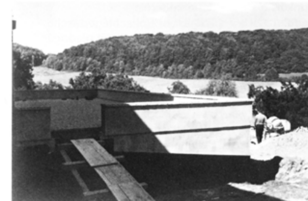
Die Terrasse ist fertig
