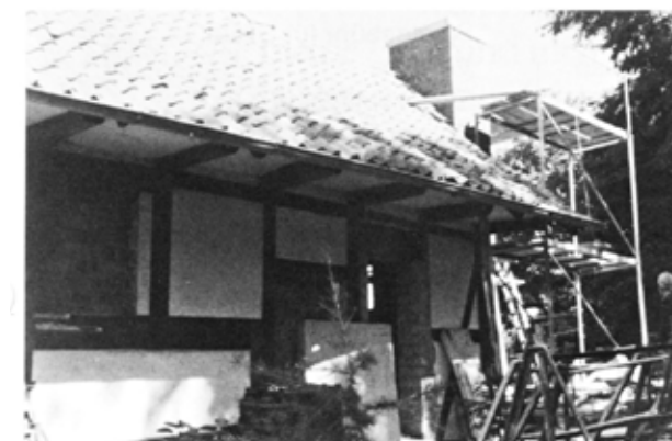
Für die Heizung ist der Anbau schon fast fertig
