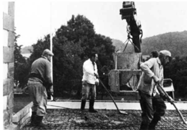
Vorbereitung zum Deckengießen
